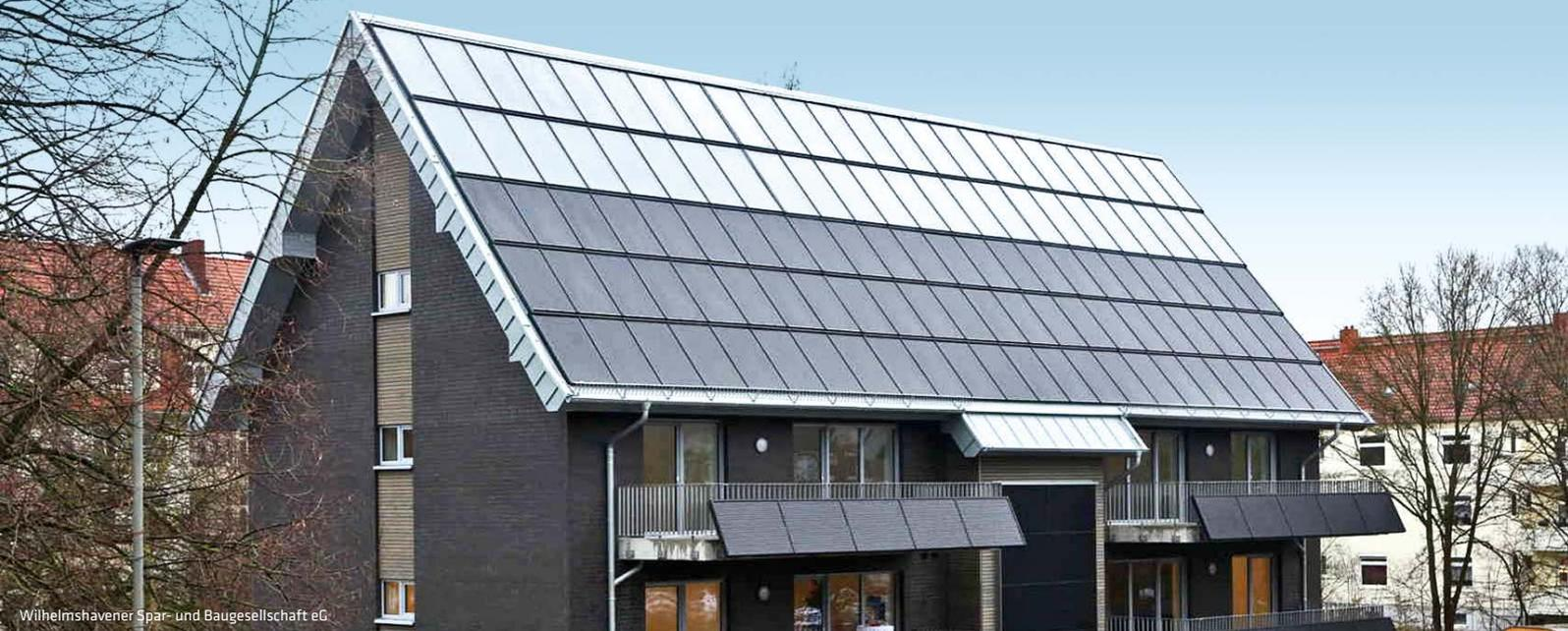
Solarthermie und Photovoltaik ergänzen sich bei diesem Mehrfamilien-Solaraktivhaus in Wilhelmshaven: Den Solarthermiekollektoren mit 96 Quadratmeter Fläche steht ein 20.000 Liter Wärmespeicher zur Seite.
